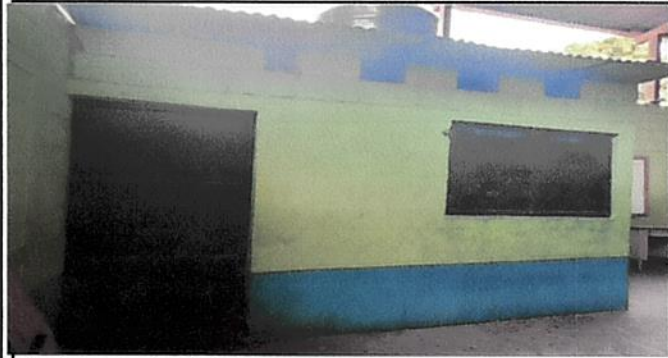
Foto 1: sustitución de lamina por lamina calibre 26
